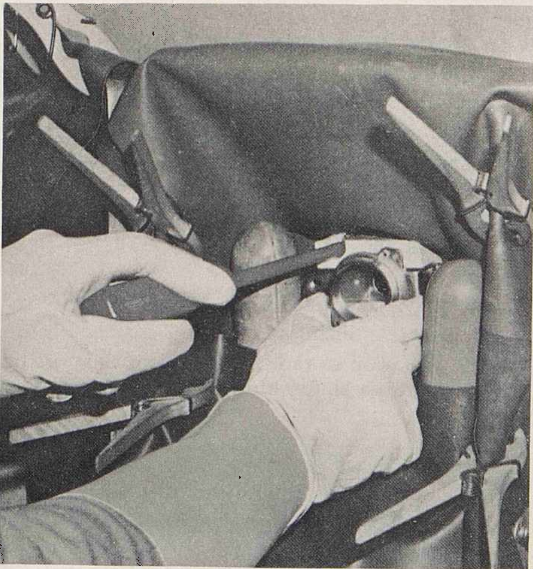
Slika 4. Rad na kabelskom kućnom priključnom ormariću
