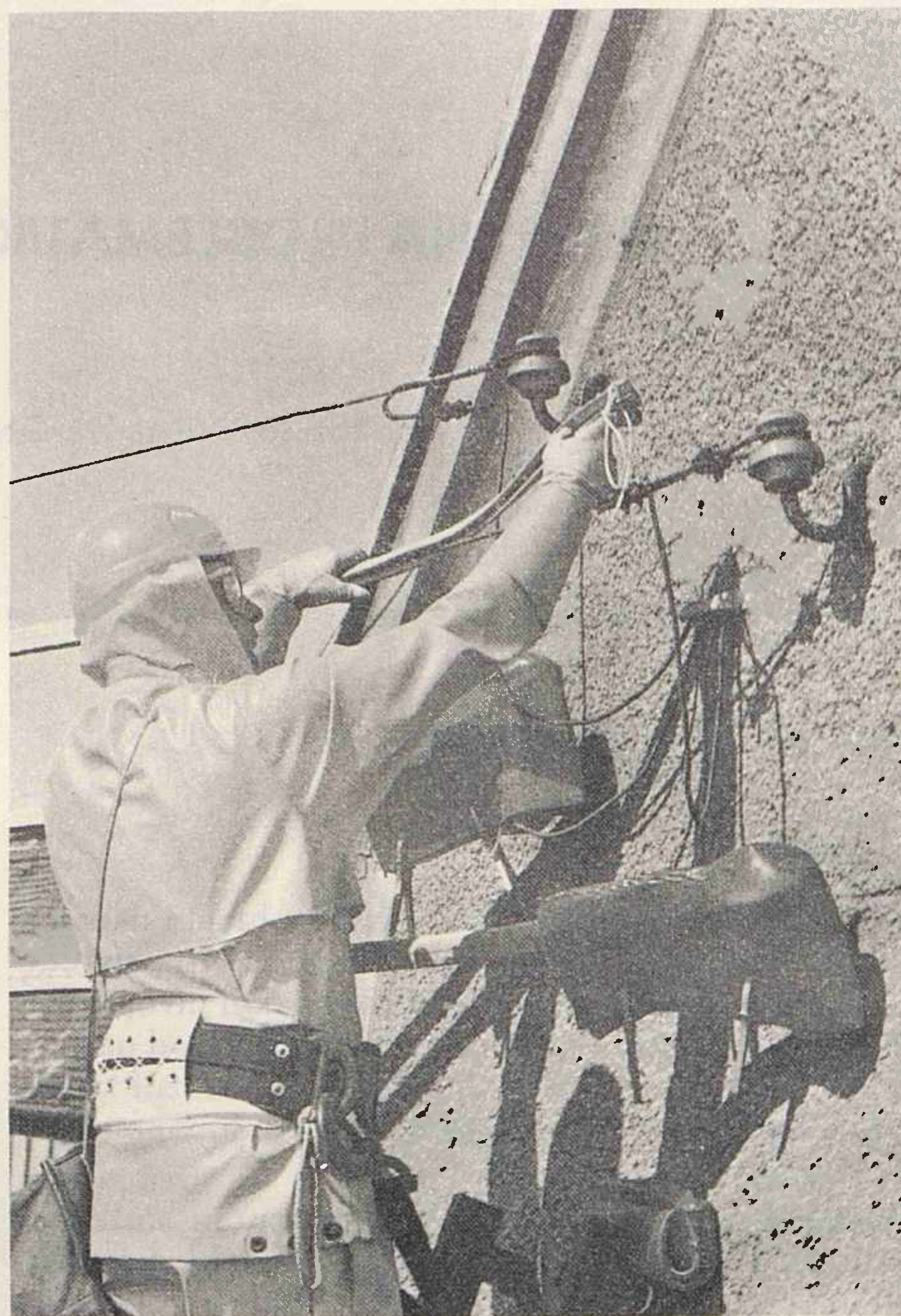
Slika 2. Rad na kućnom priključku
